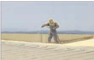
Полагане на изолация върху покрив
